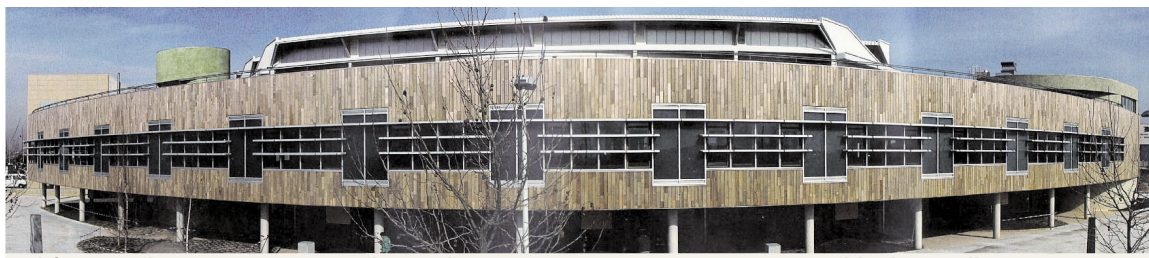
Edificio Bioclimático 'Envite', que logró el primer Premio Construcción Sostenible de Castilla y León.
