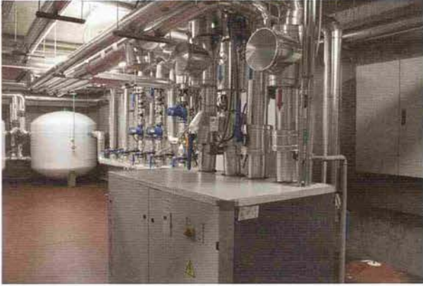
Bomba de calor agua-agua geotérmica de 80kW térmicos
