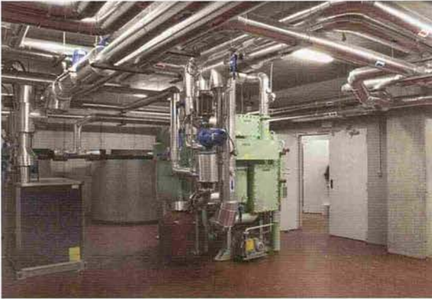
Enfriadora de agua por absorción de 260 kW
