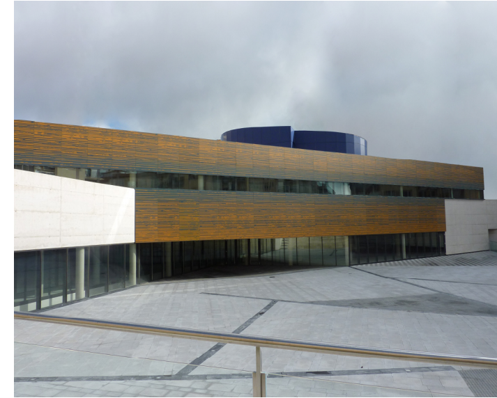
EDIFICIO SOCIAL-CAJA DE DUERO (SALAMANCA). POTENCIA INSTALADA: 800 kW. (Instalación mixta VRV-AGUA).
