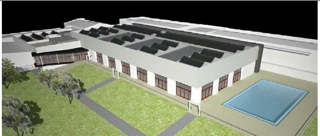
CLIMATIZACIÓN PISCINA OLÍMPICA CUBIERTA "LA SINDICAL" AYTO. ZAMORA POTENCIA INSTALADA: 1.200 kW. INSTALACIÓN SOLAR: 200 PLACAS (540 m 2 )
