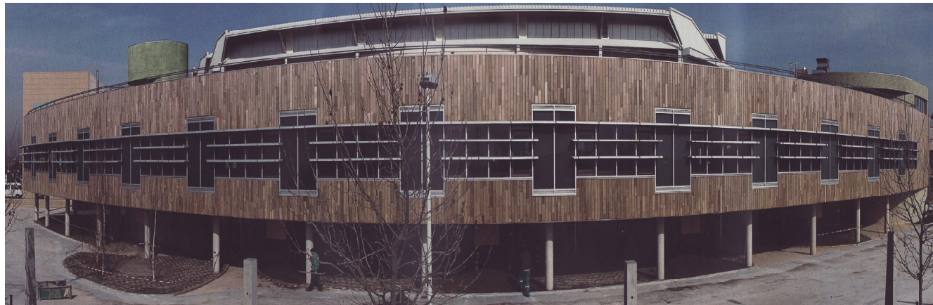
*Instalaciones proyectadas por Iván San José – Cristina y E. Serna (Dpto. de Ingeniería de Tecnaire)
